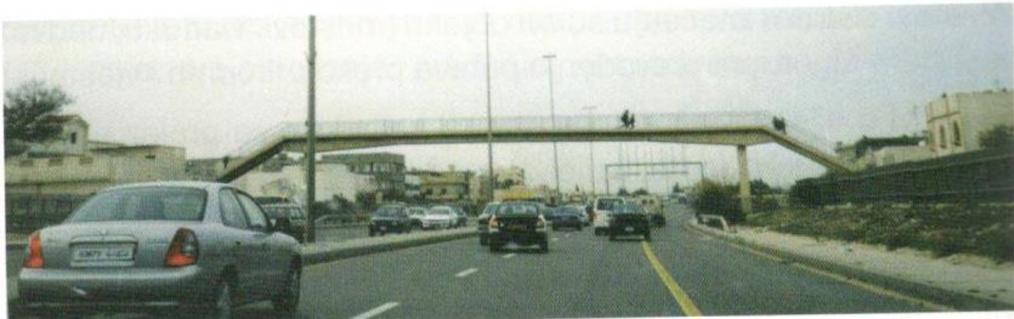
Pasarela – Nadhod za pješake
